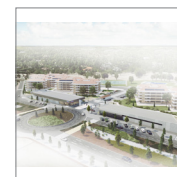
Supermarkt und Fitnesscenter Supermercado y gimnasio Pozuelo de Alarcón, Madrid. Neubau. Leistungsphasen 1-9. 2015 - 2017
