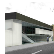
Einkaufszentrum Supermercado Madrid Zentrum. Neubau. 2016 - 2017
