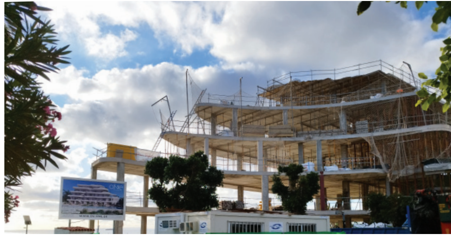
Estado actual de la obra 09/2023
