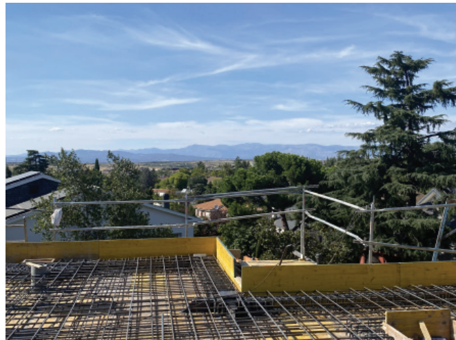
Estado actual de Obra 09/2023
