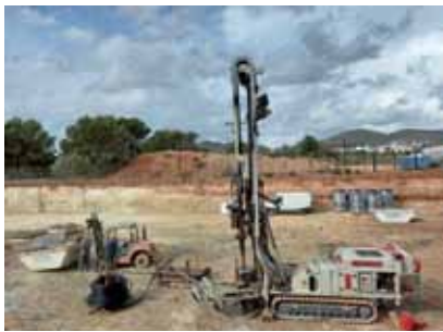
Para realizar la obra geotérmica se confió en la experiencia de GEOTER.
