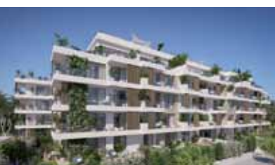
EDIFICIO DE VIVIENDAS EXCLUSIVAS Y SPA, HIPPIEMENTS, IBIZA.
